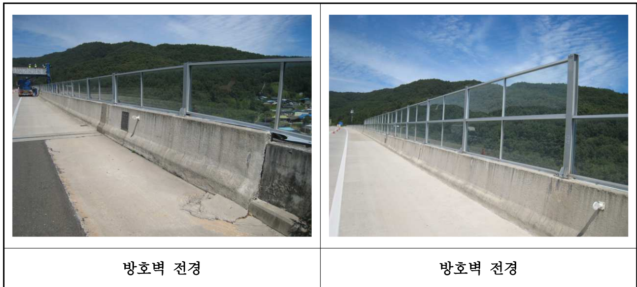
【사진 9.3.23】 방호벽 및 중앙분리대 전경
