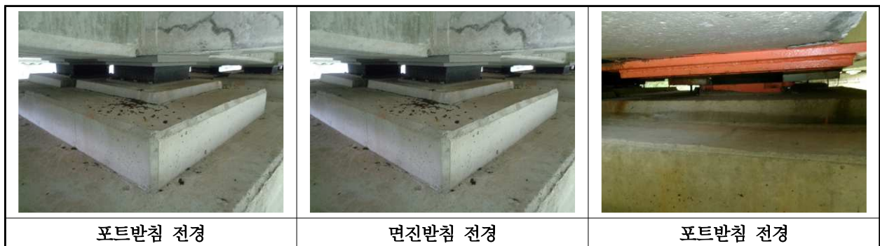
【사진 9.3.12】 교량반침 전경
