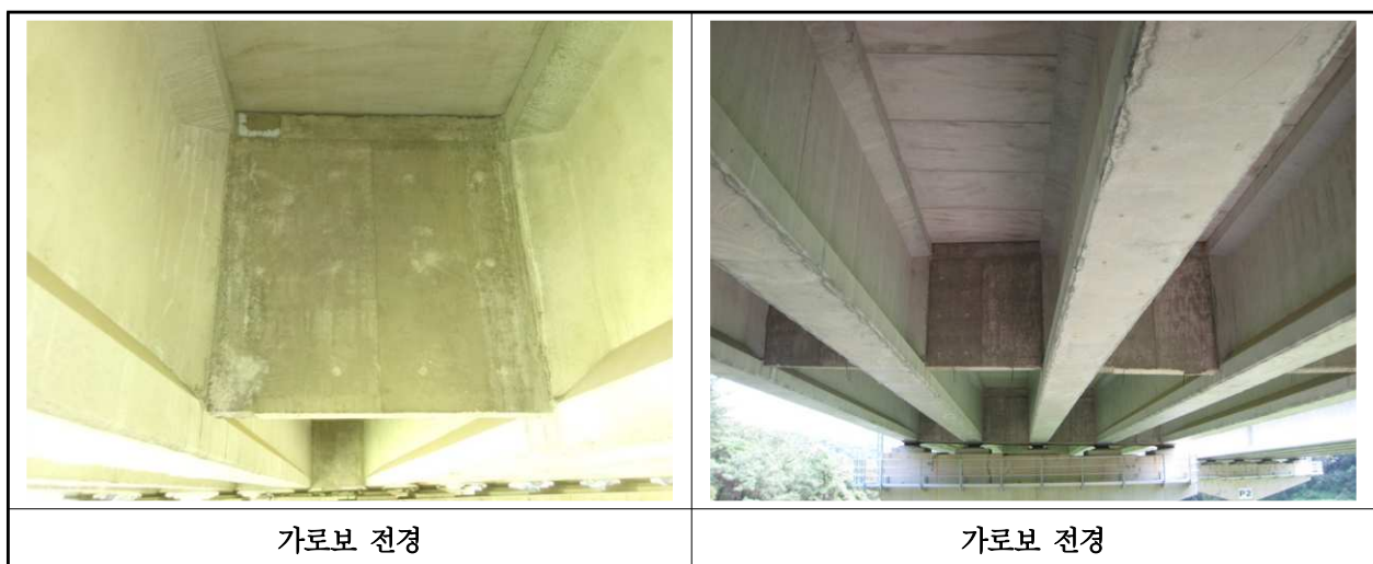
【사진 9.3.6】 가로보 전경
