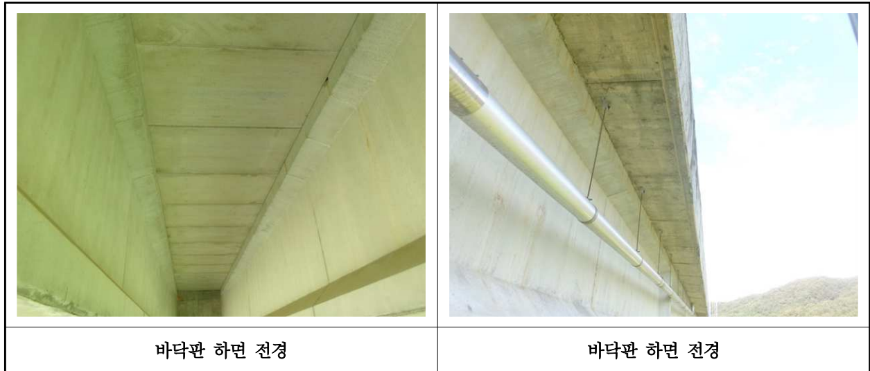
【사진 9.3.2】 바닥판하면 전경
