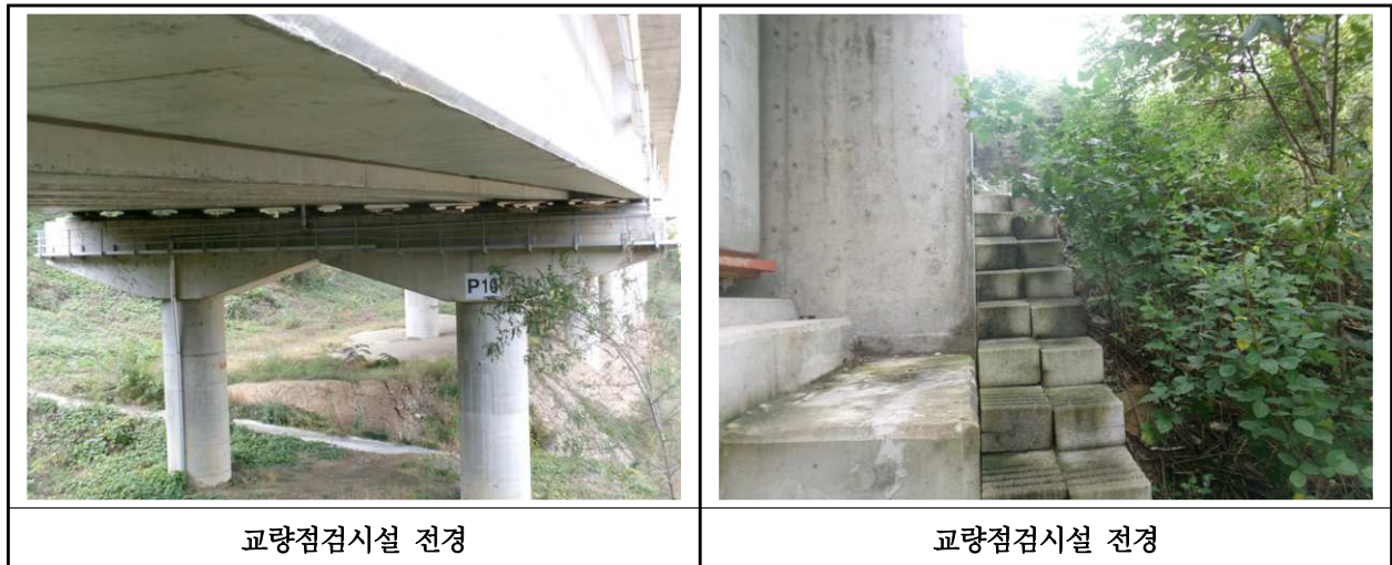
【사진 9.3.25】 교량 점검시설 전경
