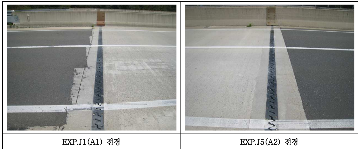
【사진 9.3.41】 신축이음장치 전경
