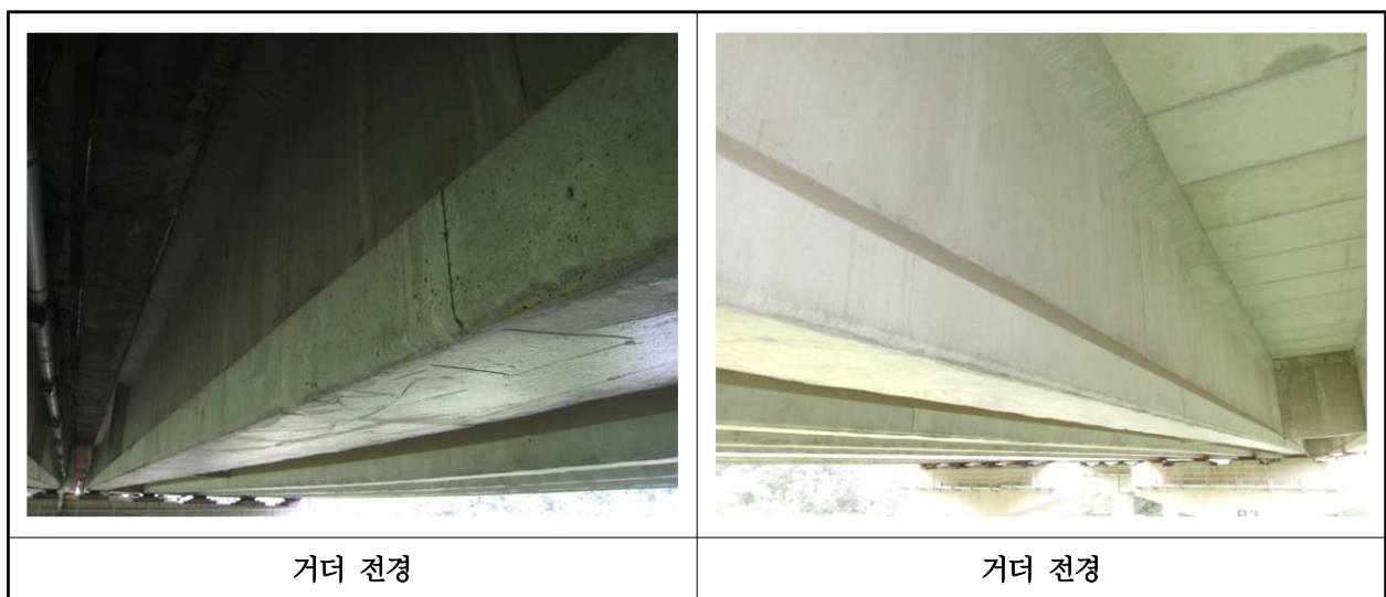
【사진 9.3.4】 거더 전경
