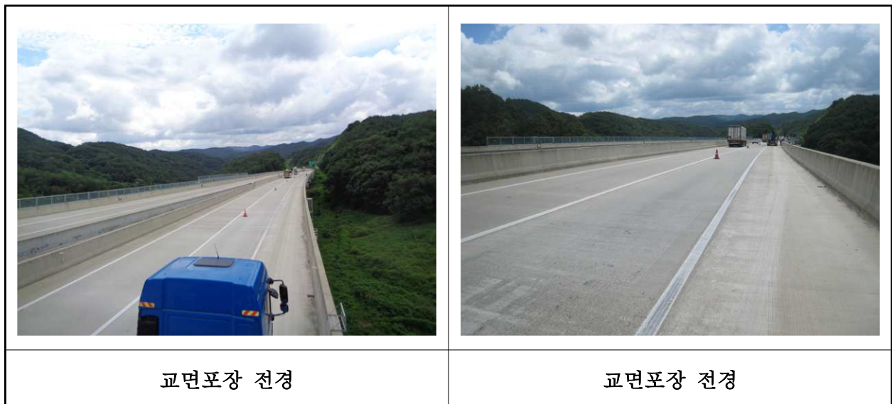
【사진 9.3.44】 교면포장 전경
