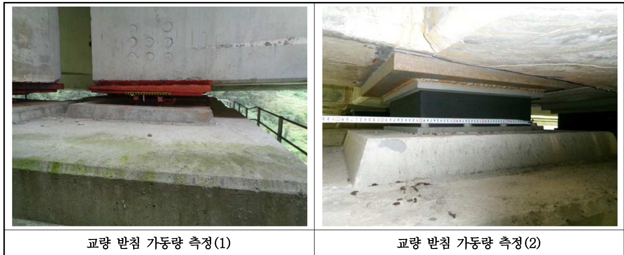
【사진 9.3.40】 교량받침 이동량 측정
