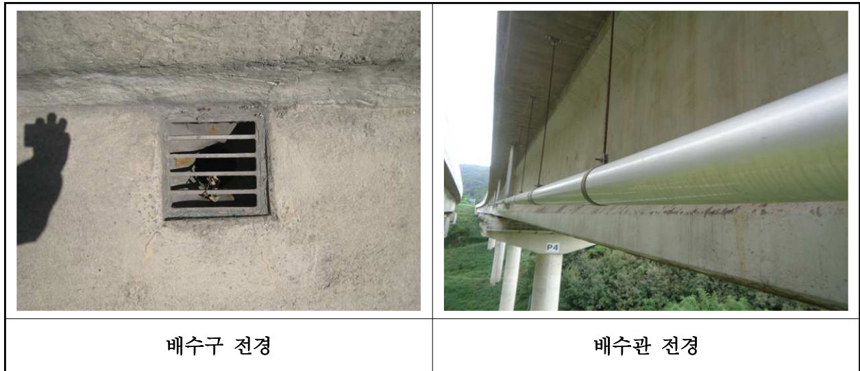
【사진 9.3.21】 배수시설 전경
