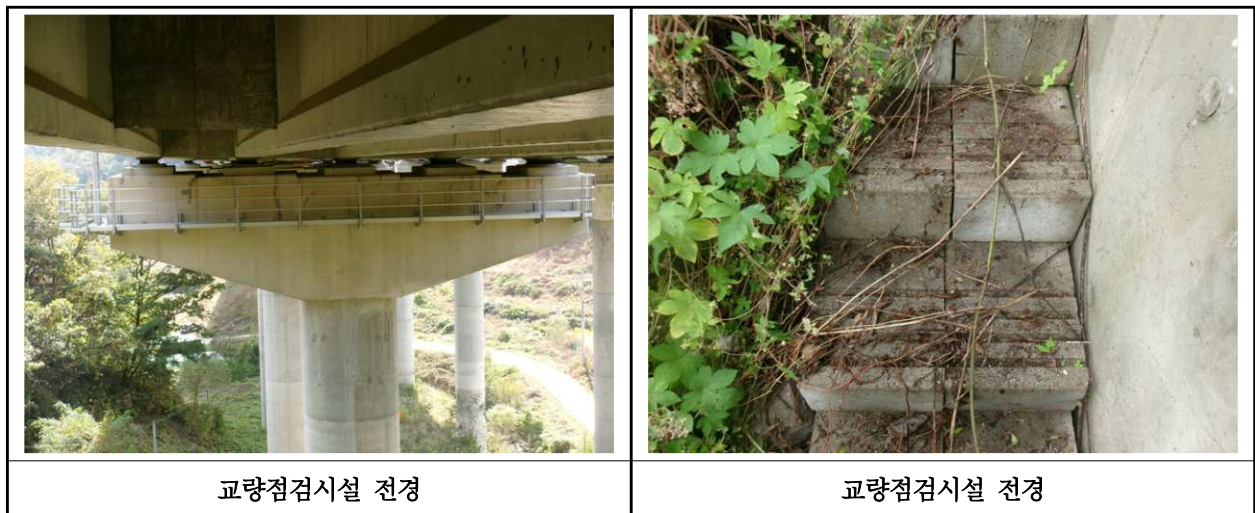
【사진 9.3.50】 교량 점검시설 전경
