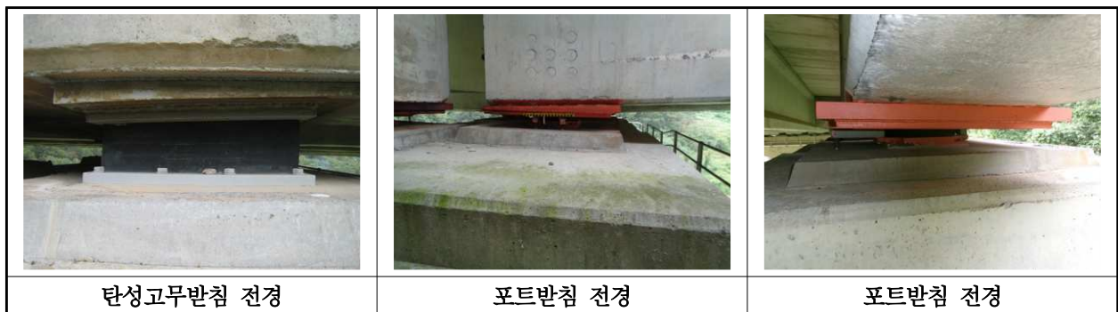
【사진 9.3.37】 교량반침 전경
