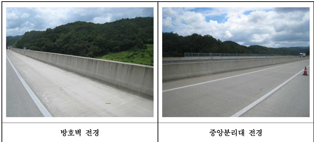
【사진 9.3.48】 방호벽 및 중앙분리대 전경
