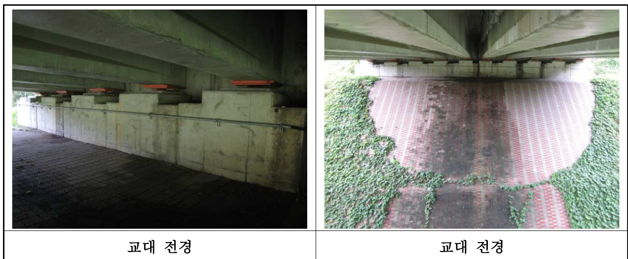
【사진 9.3.8】 교대 전경
