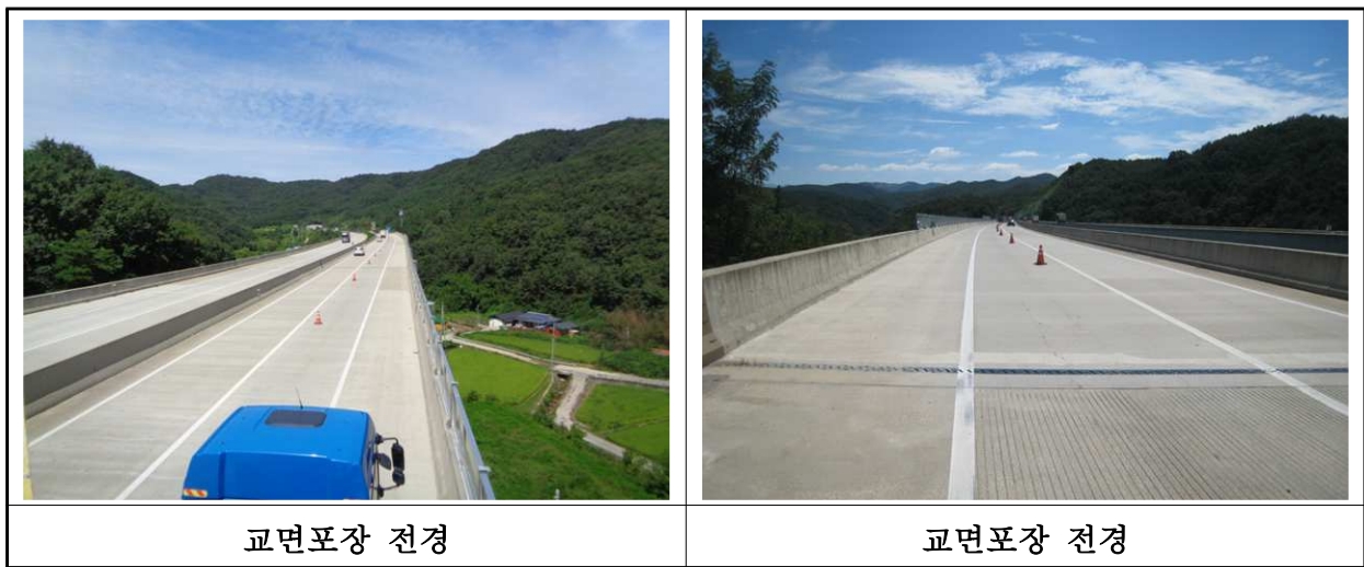
【사진 9.3.19】 교면포장 전경
