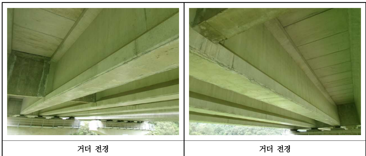
【사진 9.3.29】 거더 전경
