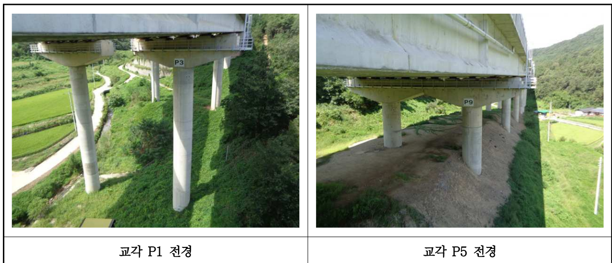
【사진 9.3.10】 교각 전경
