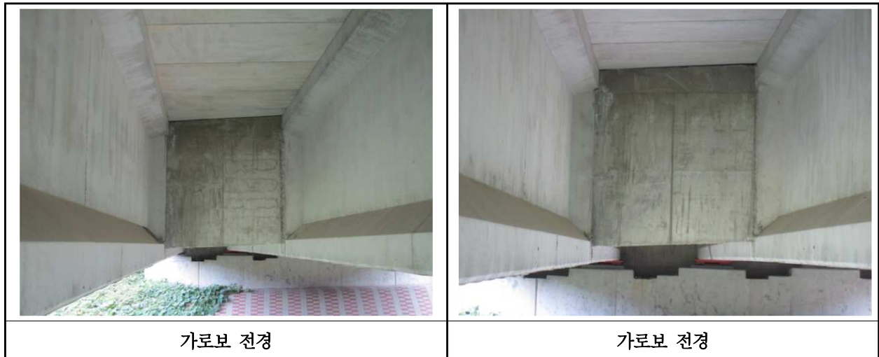
【사진 9.3.31】 가로보 전경
