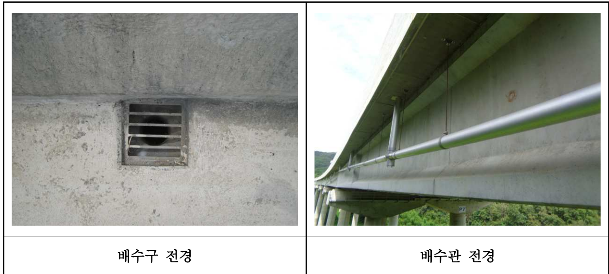
【사진 9.3.46】 배수시설 전경
