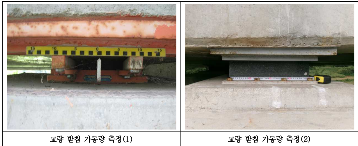
【사진 9.3.15】 교량받침 이동량 측정
