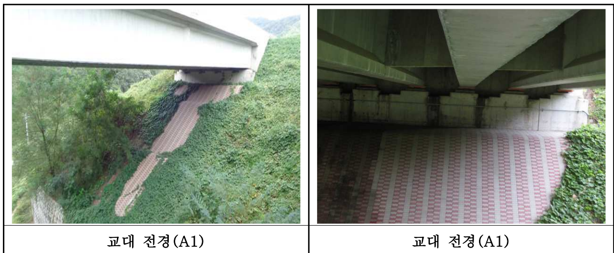
【사진 9.3.33】 교대 전경
